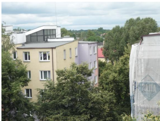
Świetliki w ramach stalowych przed wymianą
