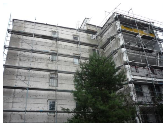
Elewacja południowa w trakcie remontu
