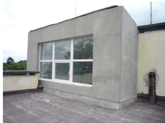
Przebudowa świetlika (w trakcie realizacji)
