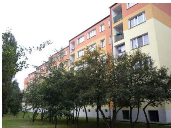
Zakończony remont elewacji północnej i wschodniej
