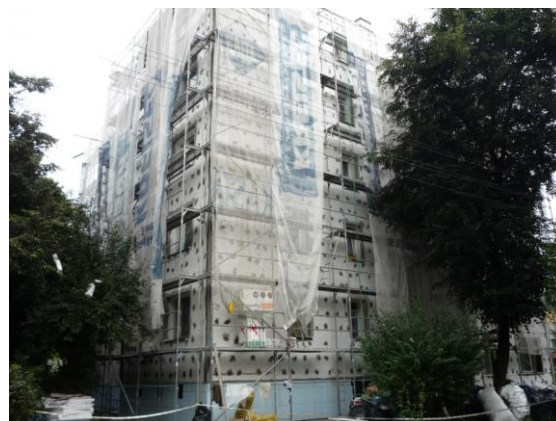
Budynek Sienkiewicza 47A w trakcie robót
